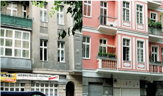
Abb. 1 und 2: Fassadensanierung als Zeichen von räumlicher Aufwertung im Quartier, Berlin-Neukölln (Quelle: eigene Aufnahmen)
